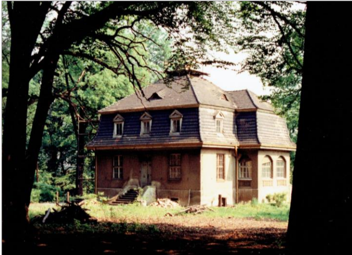
Abb. 6: Zustand der ersten Villa am Oberweg im Jahre 1990, kurz vor ihrer Sanierung (Hans Schmidt, Bad Muskau).
